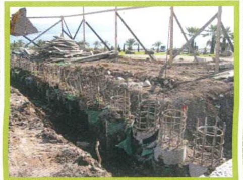
השרוול לקבלת מעטפת נקייה של קיר כלונסאות
