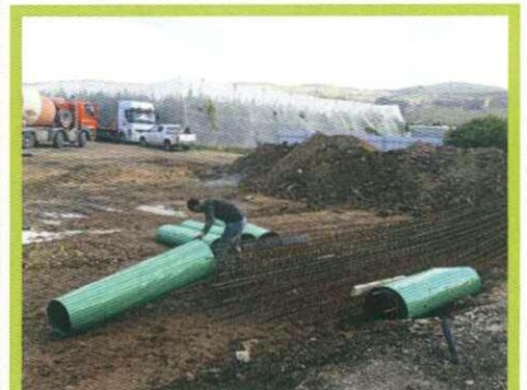
קשירת השרוול הטלסקופי לכלובי הזיון בשיטת CFA
